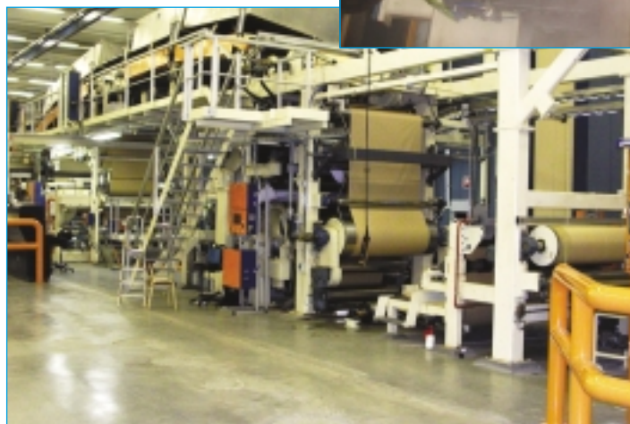
Dans cette installation d'incinération des déchets, AutoJet a été chargé de refroidir la température des gaz de combustion.
